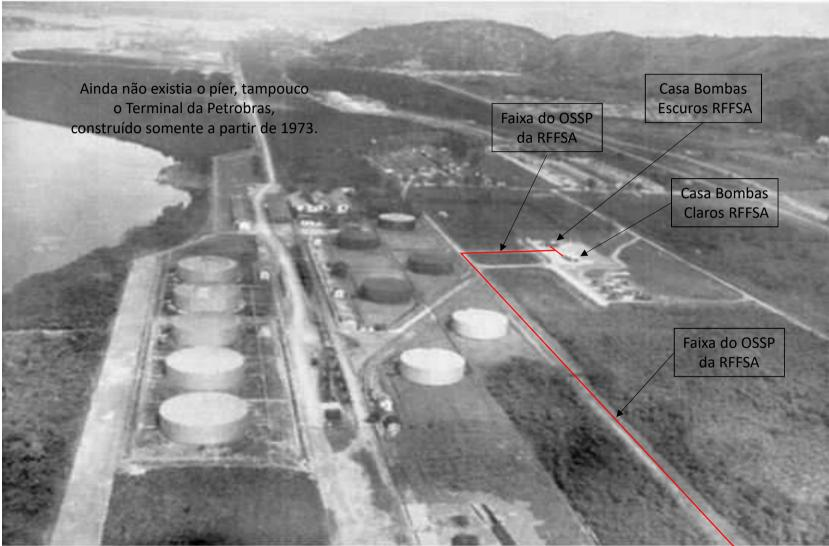
Instalações na Alemoa para o recebimento de petróleo e óleo combustível, descarregados pelos navios-tanques no cais do Saboó, que se vê ao fundo, à esquerda, e transportados por linhas de oleoduto. Os tanques possuem uma capacidade para receber 537.132 barris
